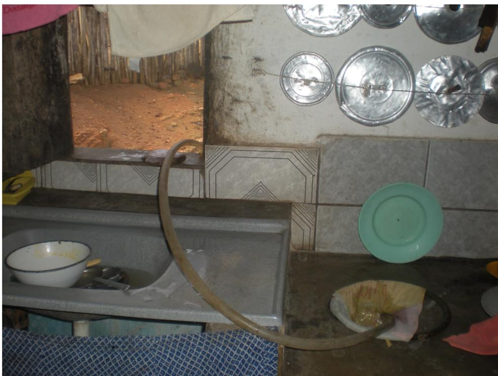
À défaut d'installer un système de canalisation à l'intérieur de la maison, le tuyau permet de remplir le réservoir de la cuisine. L'eau sera ensuite prélevée manuellement pour faire la vaisselle, remplir les casseroles d'eau de cuisson ou encore nettoyer les aliments.
