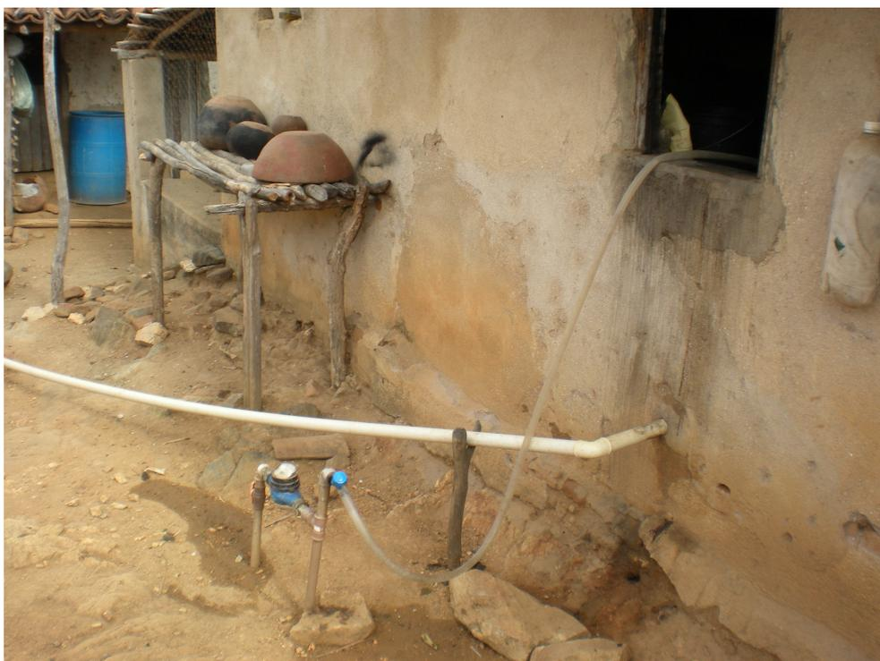
Le compteur d'eau individuel est placé dans l'arrière-cour de la maison. Un tuyau de raccordement est passé par la fenêtre de la cuisine pour adapter le dispositif aux usages domestiques. Une canalisation (blanche) permet de récupérer les eaux de vaisselle pour arroser plus loin quelques plantations.
