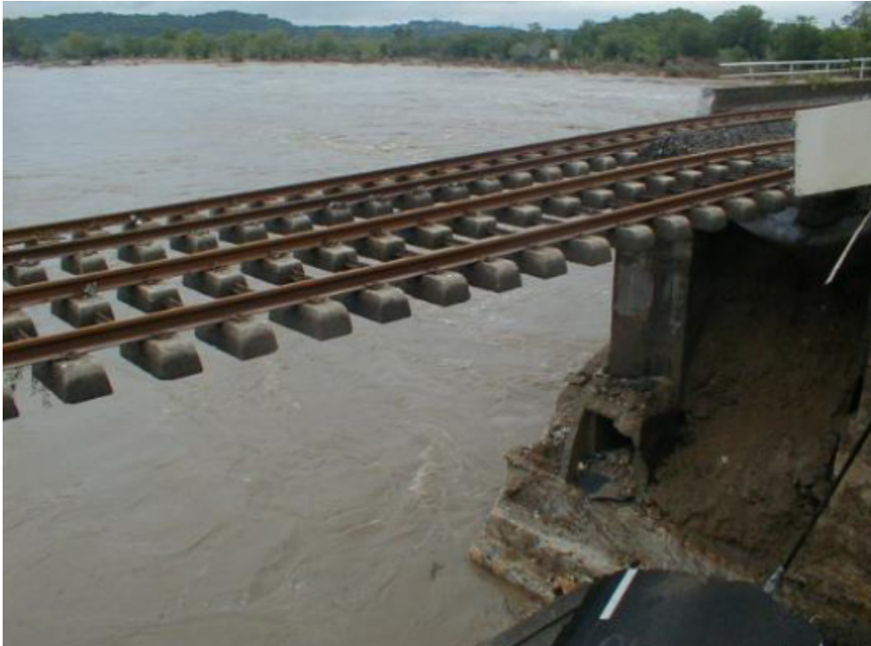
Figure 4a. Accidents régulièrement mentionnés. Effet de la crue du Gardon en 2002 sur la ligne Nîmes-Alès.
