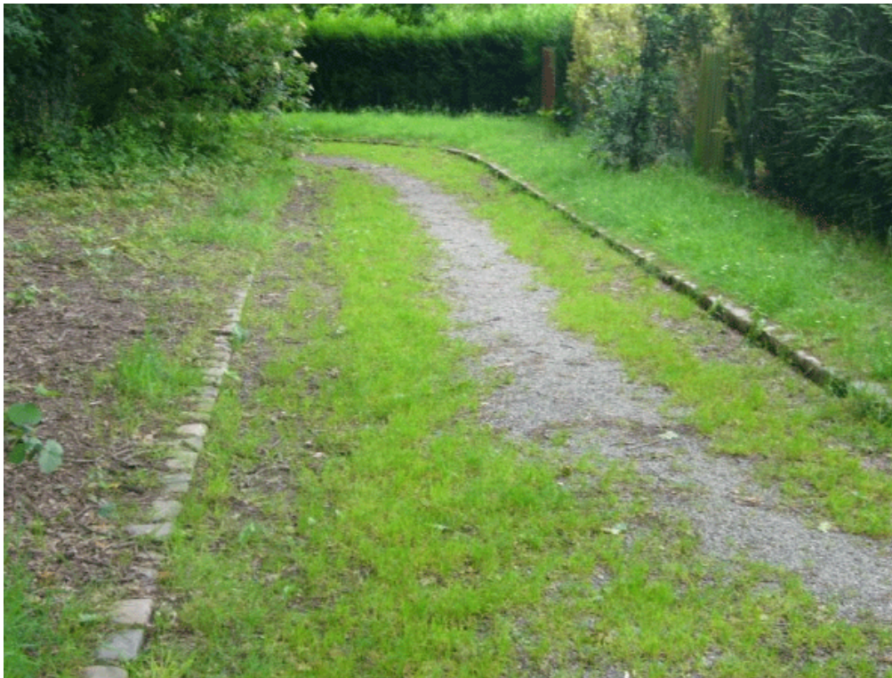
Figure 4. L'herbe gagne les anciennes allées, Rennes. Autrefois bien tracées et régulièrement désherbées, elles sont désormais colonisées par la végétation. Subsistent les anciennes bordures, Quartier de Patton.
