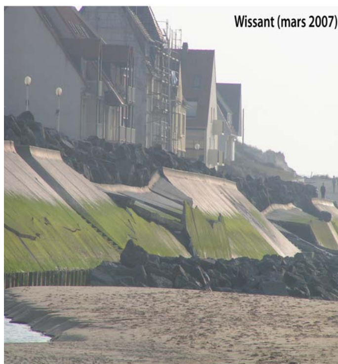
Figure 4. Photographies de la digue et de la plage de Wissant en 1998 et suite à la tempête du 19 mars 2007 (Cliché du haut : O. Cohen ; cliché du bas : V. Herbert ) Légende : noter l'important abaissement du niveau de sable sur le haut de plage.
