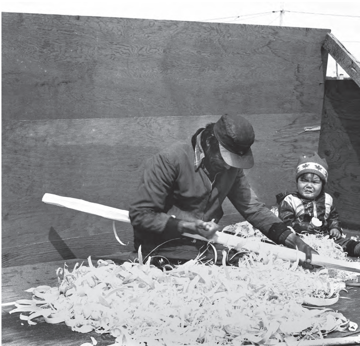
Fabrication d'une rame à l'aide d'un couteau croche
