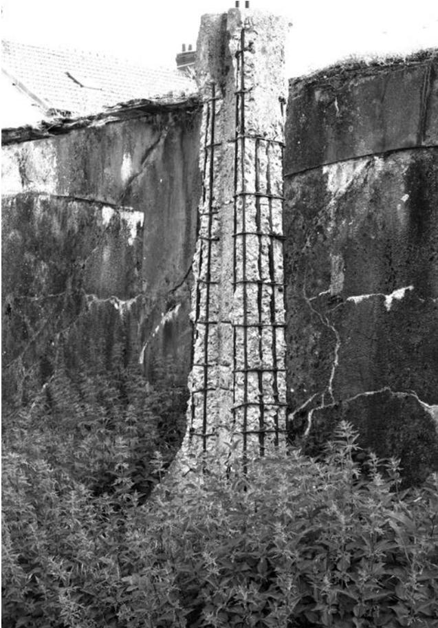
**Poteau rongé jusqu'au fer sur la presqu'île de Caen. « Remarquez le joli poteau sur la droite comme un totem. Il est usé par le temps et le sel, le fer enserre le béton fait de ciment et de granulats bruns. C'est comme un éclaté qui révèle l'intérieur de cette matière et la technique du béton armé. »**
