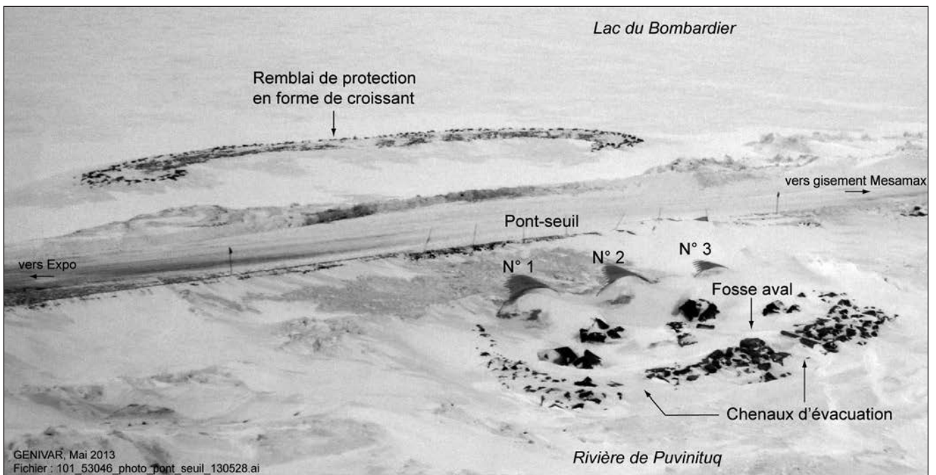
Figure 5. Aménagement de la fosse en aval du pont-seuil du lac du Bombardier, Nunavik, printemps 2013. Notez le remblai en forme de croissant présent à l'amont des ponceaux pour leur protection contre les glaces.
