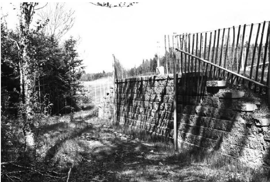
Figure 2. Un des 30 sautoirs installés dans le ravage de cerfs de Virginie de Calway dans le secteur du prolongement de l'autoroute Robert-Cliche (73), Saint-Joseph-de-Beauce, Québec. En haut: Vue de la pente douce du côté de l'autoroute. Ci-dessus: Vue du mur vertical du côté de la forêt.
