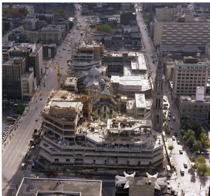
ILL. 24. CONSTRUCTION DE LA PHASE 1 DE L'UQAM (V. 1977). | ARCHIVES DE LA VILLE DE MONTRÉAL.
