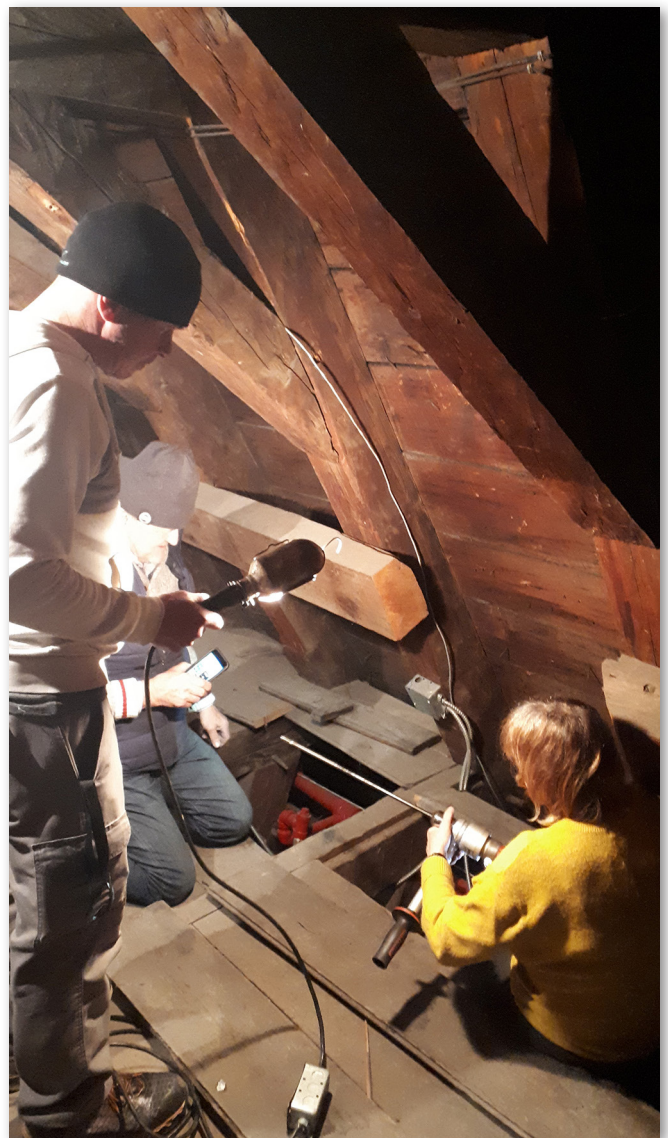
Carottage de la charpente de l'église du monastère de l'Hôpital général de Québec, 25 janvier 2020. Photo : Monastère de l'Hôpital général de Québec.
