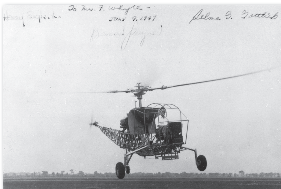
Le premier vol du SG-VI-C, Dorval, 9 juillet 1947. Les signatures des concepteurs de l'hélicoptère, Bernard W. Szynger et Selma G. Gottlieb, et du pilote, Henry J. Eagle, Jr., sont visibles. (Source : MAEC, négatif no 13099)
