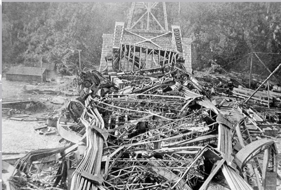
Écroulement du pont de Québec survenu le 29 août 1907, causant la mort de 76 ouvriers.
