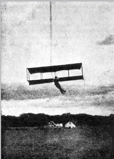
Lesh et son planeur tiré par un cheval au galop en 1907. Noter le câble de traction. (Source : Scientific American , Oct. 1907)
