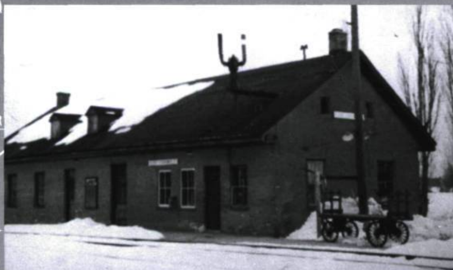
La vieille gare de Chambly-Canton, érigée en même temps que les autres le long de la ligne de chemin de fer qui fut inaugurée au cours de la décennie 1870, vers 1950.
