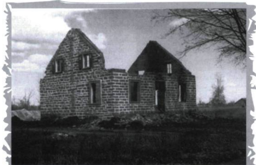
Maison ancestrale incendiée par les Fédéraux. (Photo : Gilles Boileau)
