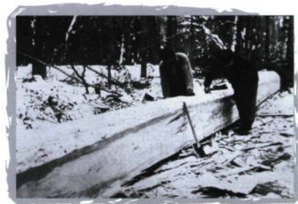
Équarrissage d'une pièce de pin, vers 1920. Collection Pierre Louis Lapointe.
