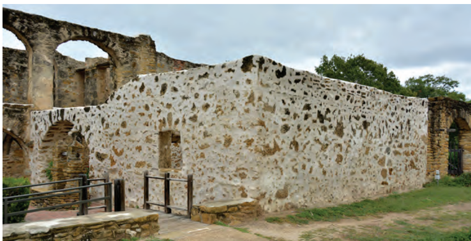
Voici un exemple d'enduit à pierre vue, réalisé sur une section restaurée des bâtiments pendant le séjour de l'auteur.
