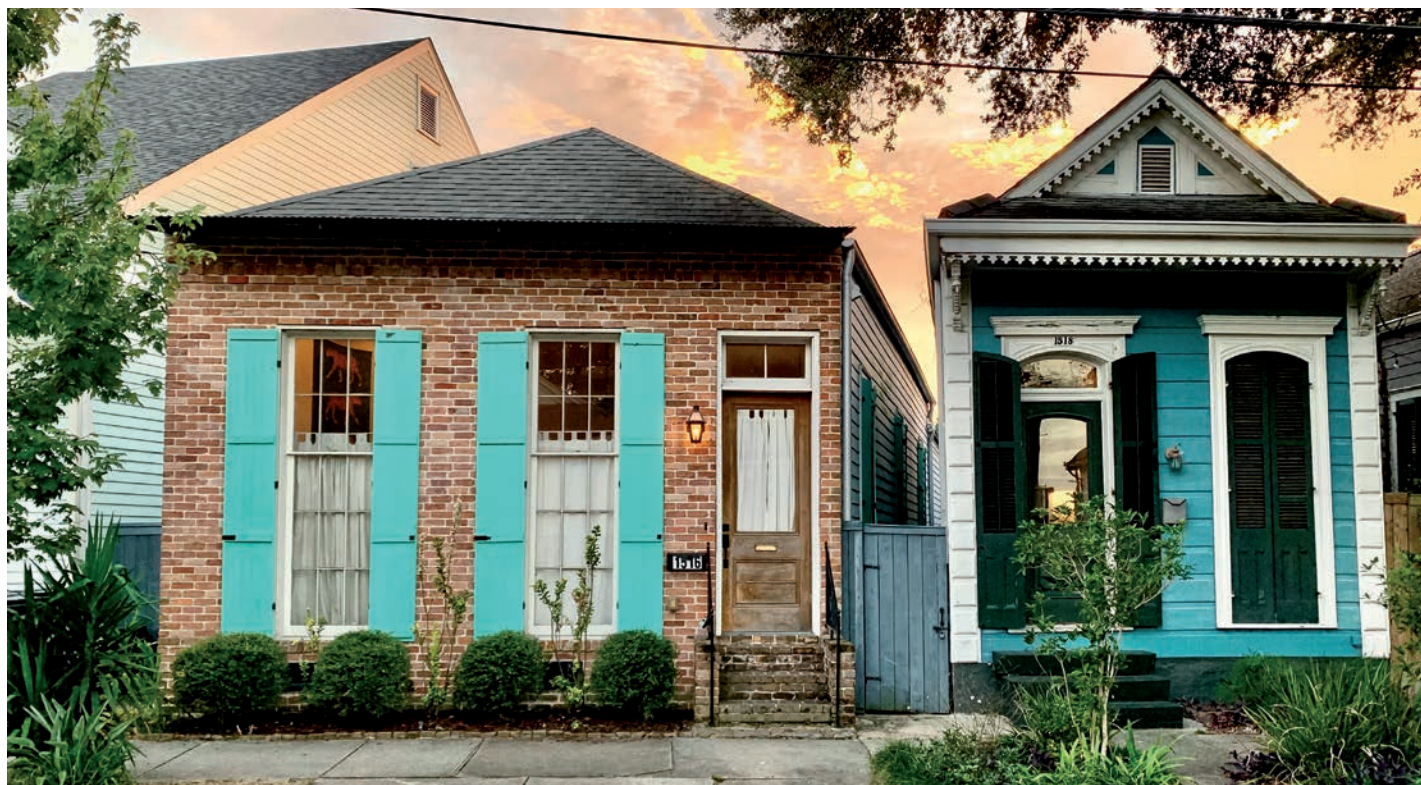
À La Nouvelle-Orléans, après une inondation, il suffit de laisser sécher les matériaux des maisons de type shotgun . Un bel exemple de la sagesse des constructeurs d'antan.
