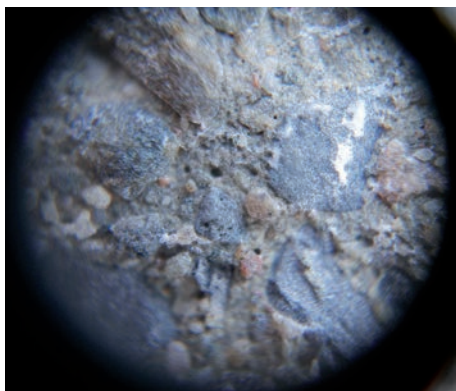
Des infiltrations d'eau répétées créent des dépôts de calthémite à la surface du béton.
