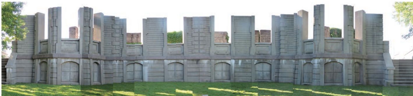
Montage de différentes prises de vue de l'arcade montrant l'état de détérioration de l'œuvre, notamment les traces blanches de calthémite.
