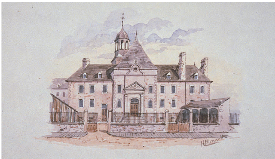
Aquarelle sur papier d'Henry Richard S. Bunnett représentant l'église des Récollets sur la rue Notre-Dame, à Montréal, avant la construction de sa nouvelle façade Source : Musée McCord, M978.71.21
