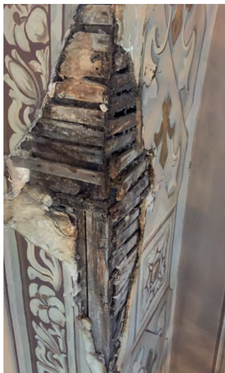
Des infiltrations d'eau ont entraîné le détachement de l'enduit à la chaux de sa base en lattis de bois.
