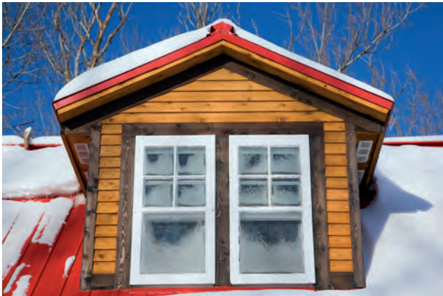
Grâce à la couche d'air qui se trouve entre ses deux vitres, la double fenêtre procure une meilleure isolation que la simple. Photo : Perry Mastrovito
