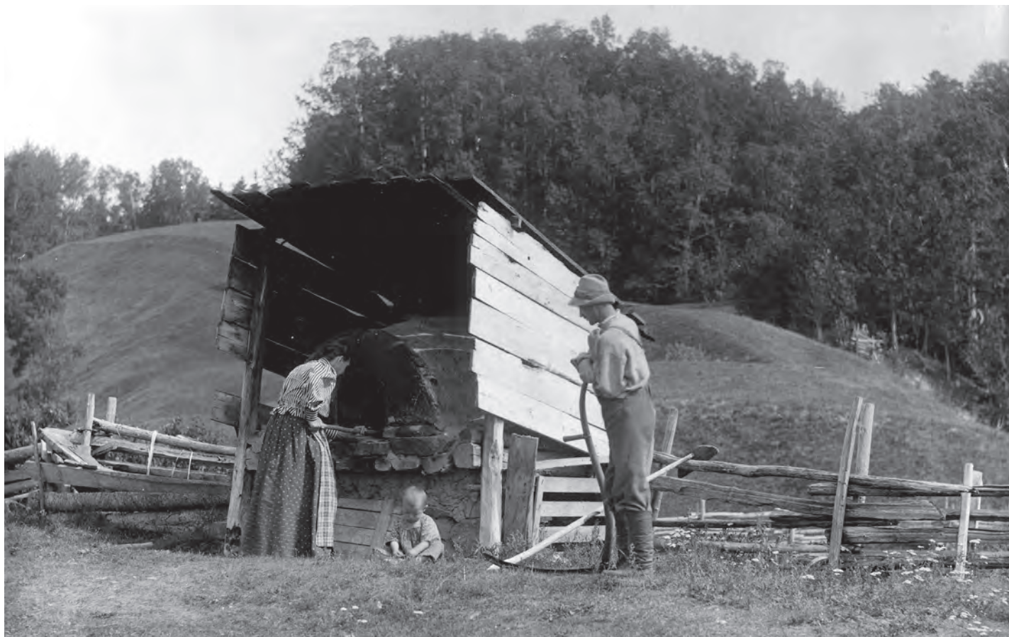
Cette photo de William F. Notman a été prise en 1900, à Cap-à-l'Aigle, dans Charlevoix. Elle montre un four à pain extérieur en argile, construit sur une assise en bois et couvert d'un abri à trois pans.
