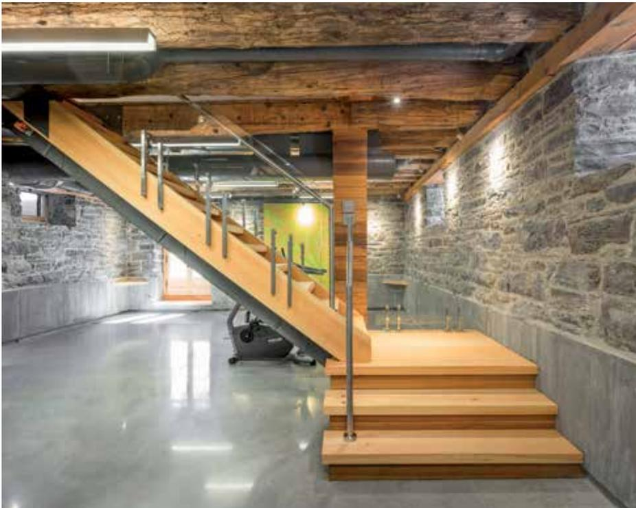
Aperçu du sous-sol, des solives et des murs en maçonnerie d'origine, après la réhabilitation. Les nouvelles insertions mécaniques (luminaires, etc.) ont été intégrées entre les solives, dans le même sens que ces dernières.
