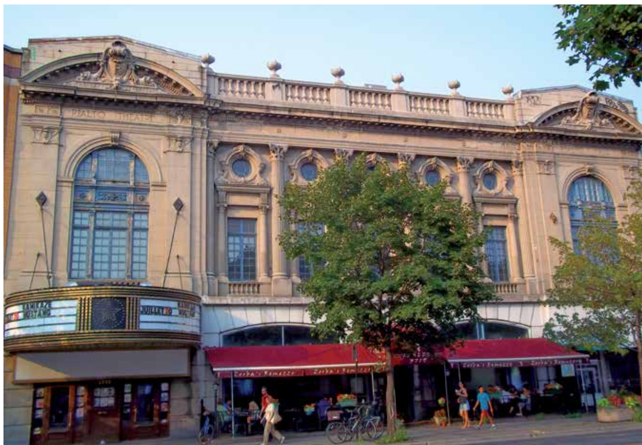
On doit plusieurs bâtiments emblématiques de la métropole à la communauté syrienne, notamment le cinéma Rialto, immeuble de style Beaux-Arts construit en 1923.
