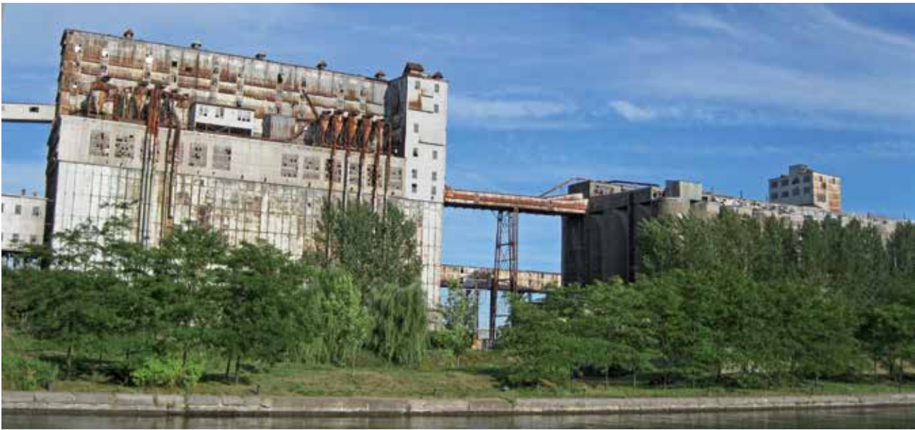
L'Association québécoise pour le patrimoine industriel réalisera une route qui mettra en valeur cet héritage bâti à Montréal. Parions que le Silo n° 5, un des derniers témoins de l'activité industrielle qui a animé le Vieux-Port au début du XX e siècle, en fera partie.
