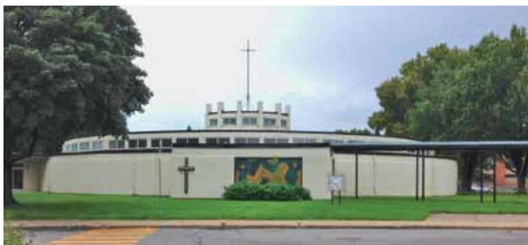
À long terme, le crépi d'acrylique qui recouvre l'édifice Gaëtan-Rousse s'est révélé perméable. On doit maintenant trouver le bon produit de remplacement.
