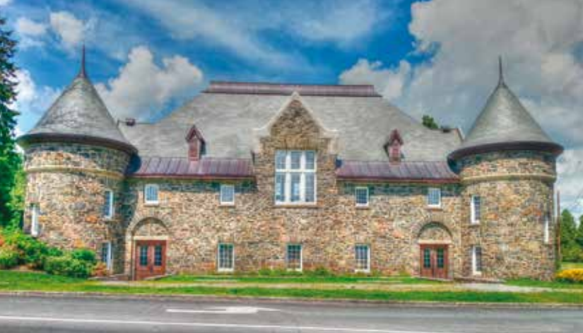
La Maison de la culture Francis-Brisson a été inaugurée en 2012 dans un ancien club social de la papetière Laurentide signé David Jerome Spence.
