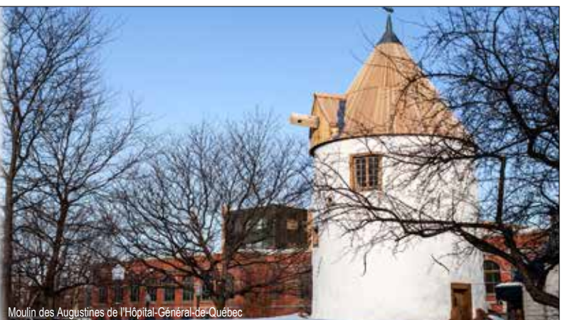
Moulin des Augustines de l'Hôpital-Général-de-Québec
