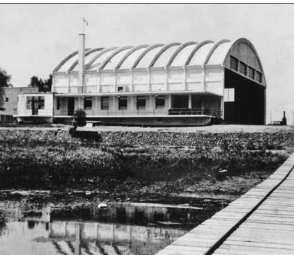
Ernest Cormier a mis à profit les compétences qu'il avait acquises en France en matière de construction en béton en réalisant ce hangar à hydravions à Pointe-aux-Trembles, en 1929.
