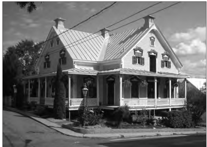
Maison de notable qui fut la résidence des abbés Geoffrion, rue Saint-Pascal.
