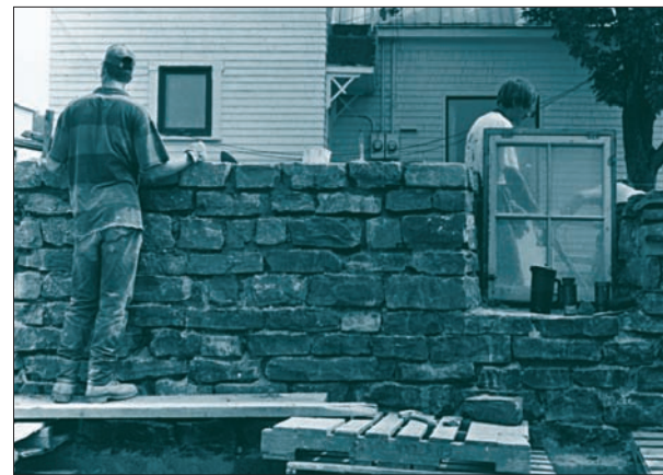
Des maçons montent un mur de pierre.
