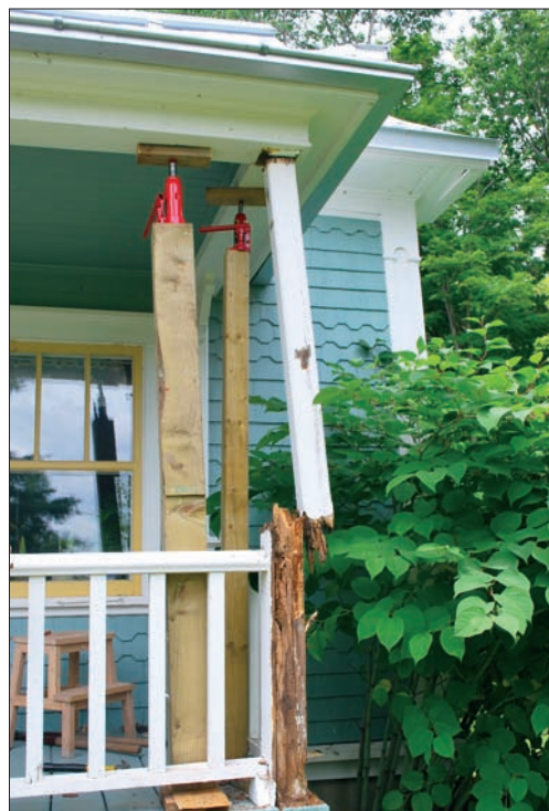
Lorsqu'on remplace une colonne, on doit placer des vérins ou des étais de bois pour supporter la structure.
