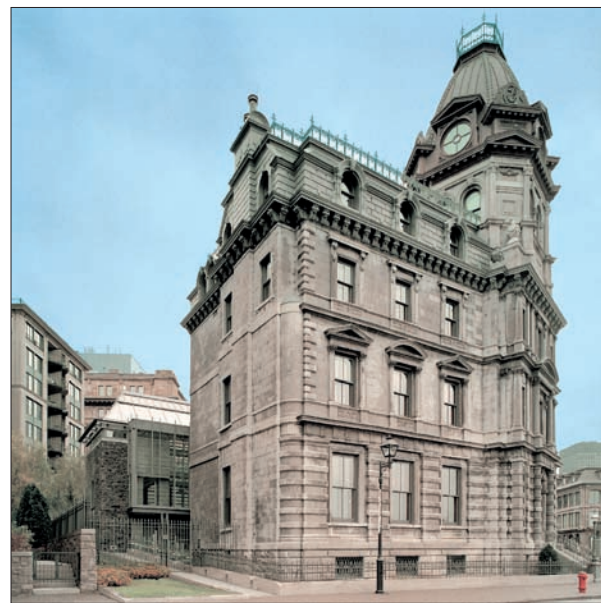
Rue de la Commune Ouest à Montréal, l'ancien édifice des Commissaires du Havre a été réhabilité en club privé, le 357C. Les fenêtres ouvrantes d'origine, en bois, ont été restaurées.
