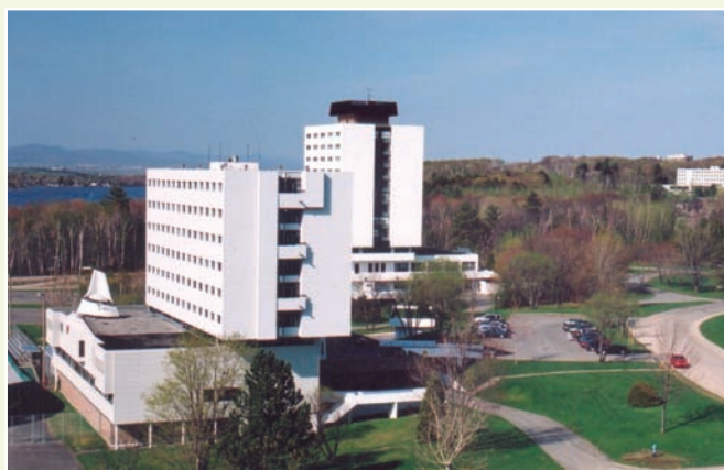
Quelques bâtiments des Campus intercommunautaires, patrimoine moderne de Saint-Augustin-de-Desmaures. Photo: Benoît LaFrance, Ville de Saint-Augustin-de-Desmaures
