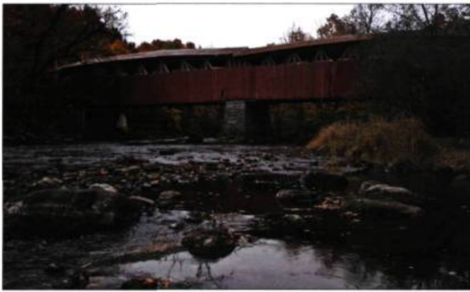
Au XIX e siècle, les constructeurs estimaient la durée de vie d'un pont couvert à 150 ans. Le pont Powerscout (aussi appelé Percy) leur a donné raison : construit en 1861, il est le plus ancien pont couvert au Canada. Unique exemplaire au monde construit en fermes McCallum, cet ouvrage classé monument historique enjambe la rivière Châteauguay à Hinchinbrooke en Montérégie.
