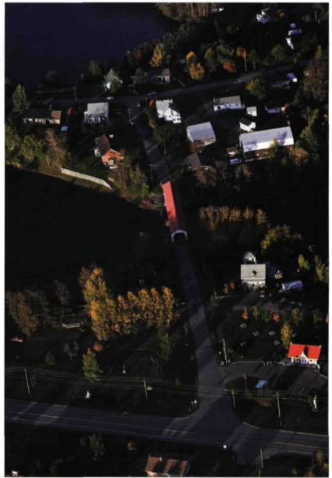
Dans le Bas-Saint-Laurent, le pont d'Amqui, construit en 1931, permet de traverser la rivière Matapédia.
