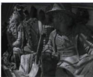
La maçonnerie restaurée du siège social de la Banque de Montréal.
