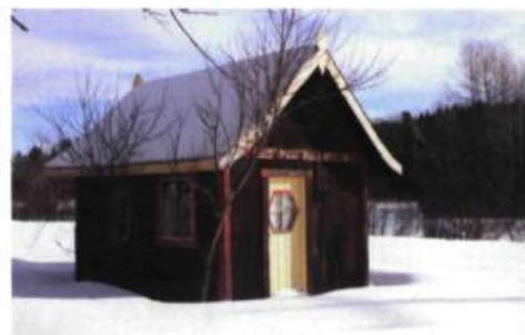
Bâtiment de service de l'ancienne station de ski du mont Bellevue à Morin-Heights.
