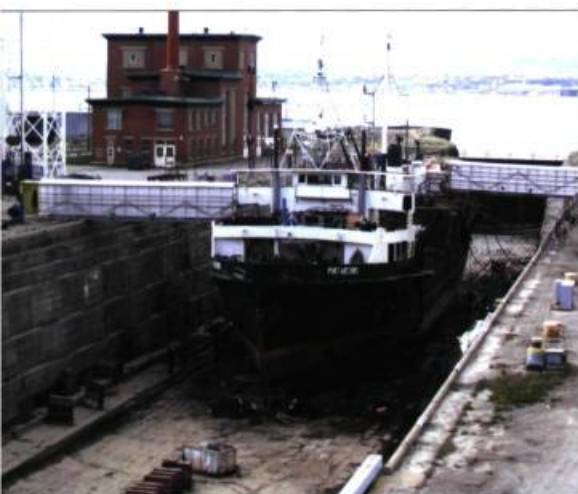
Navire en réparation dans la cale sèche Lorne, construite entre 1880 et 1886.
