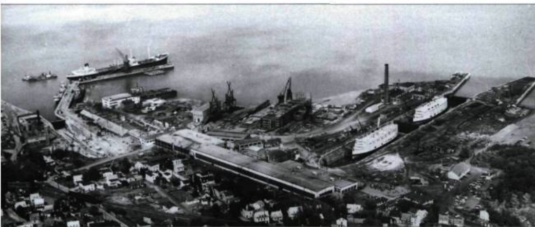
Le chantier de Lauzon est en pleine activité après la Seconde Guerre mondiale. Les bateaux blancs en cale sèche, construits vers 1927, ont fait la renommée des croisières sur le Saint-Laurent.
