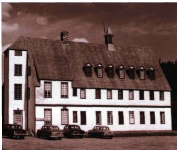
La salle à manger du Gîte du Mont-Albert en 1952. Le bâtiment a été intégré à l'architecture actuelle.
