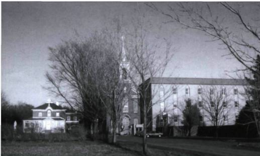
Le domaine de l'abbaye des Cisterciennes à Saint-Romuald. Un projet résidentiel prévoit la privatisation des berges de la rivière Etchemin.
