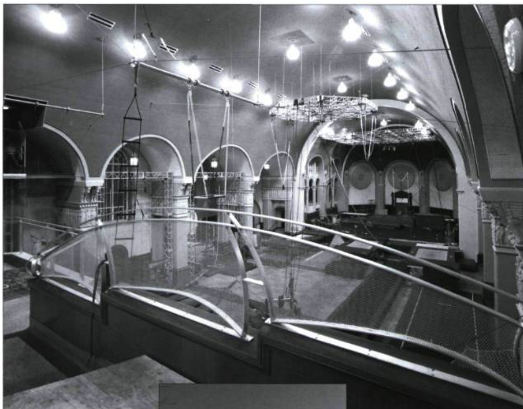
La nouvelle fonction d'école de cirque de l'église Saint-Esprit a permis de conserver intact son volume intérieur.
