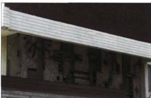
Une murale de Francisco Algora rythme la façade de l'école primaire Jean-Jacques-Olier. Avec la réforme scolaire, l'intégration de murales se généralise dans les établissements de la Commission des écoles catholiques de Montréal.
