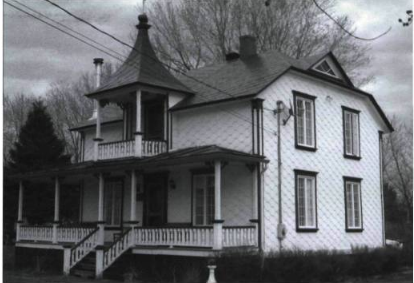
Le bardeau d'amiante est posé à la française, c'est-à-dire en diagonale de la gauche vers la droite.
