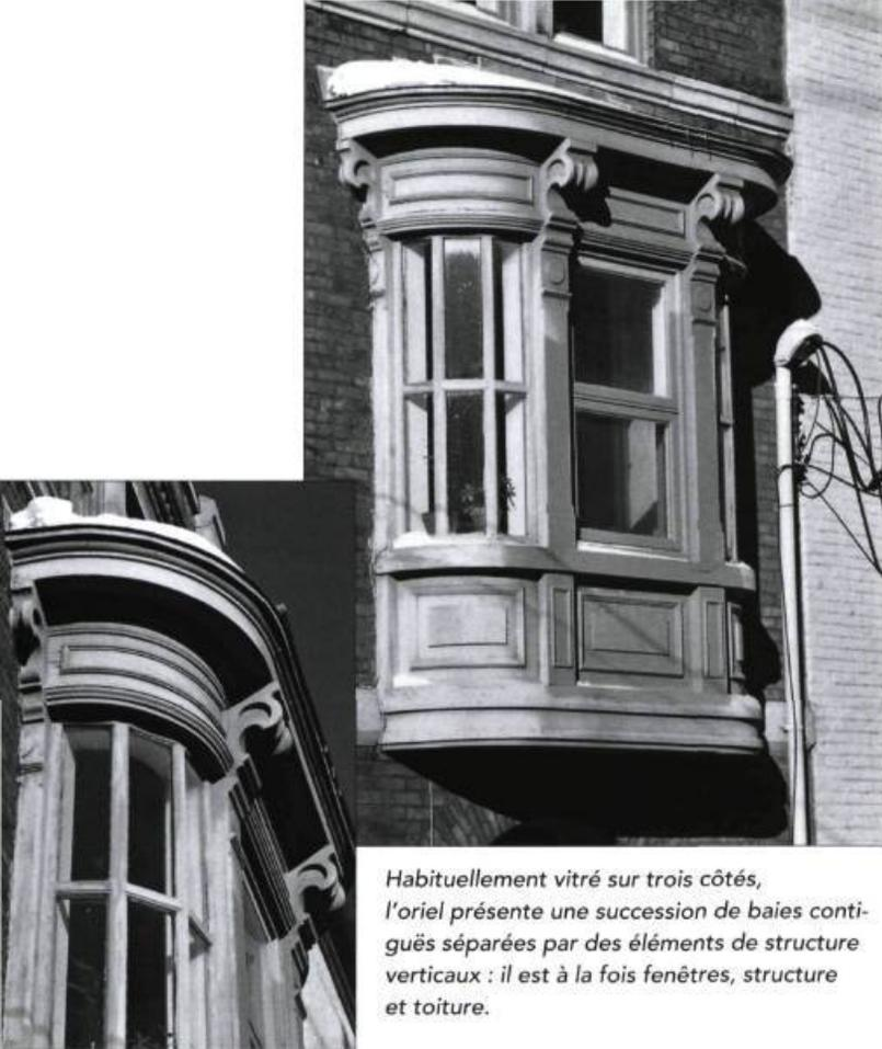
*Habituellement vitré sur trois côtés, l'oriel présente une succession de baies contiguës séparées par des éléments de structure verticaux : il est à la fois fenêtres, structure et toiture.*
