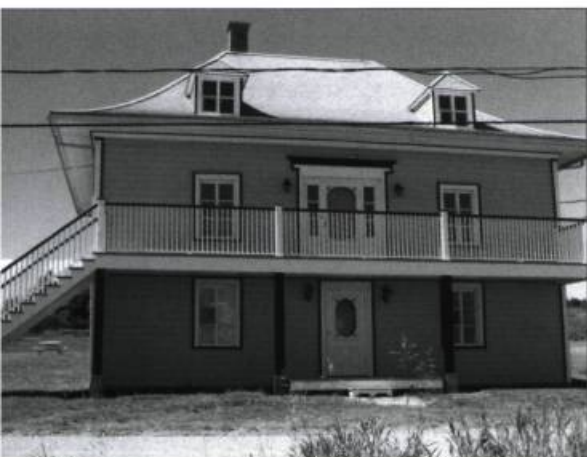
L'ancien presbytère de l'île Verte récemment restauré.
