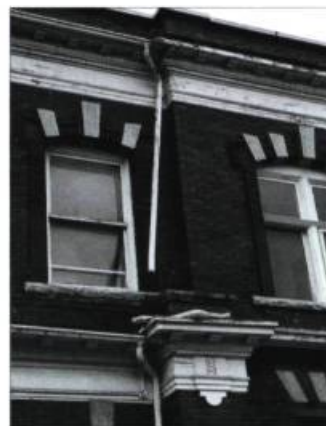
Une gouttière mal entretenue ou défectueuse concentre une grande quantité d'eau à un même endroit. Cette eau sature la maçonnerie et, sous l'action des cycles de gel et de dégel, en affecte la stabilité, d'abord en surface, puis en profondeur.
