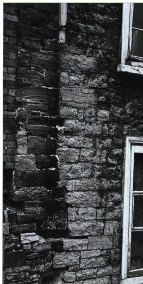
Une gouttière mal entretenue ou défectueuse concentre une grande quantité d'eau à un même endroit. Cette eau sature la maçonnerie et, sous l'action des cycles de gel et de dégel, en affecte la stabilité, d'abord en surface, puis en profondeur.
