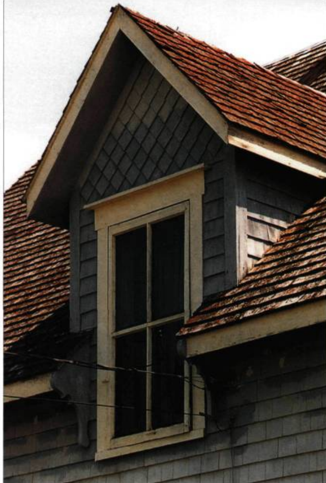
Ici, une lucarne à fenêtre pendante interrompant l'avant-toit avec ailerons et bardeaux décoratifs.
