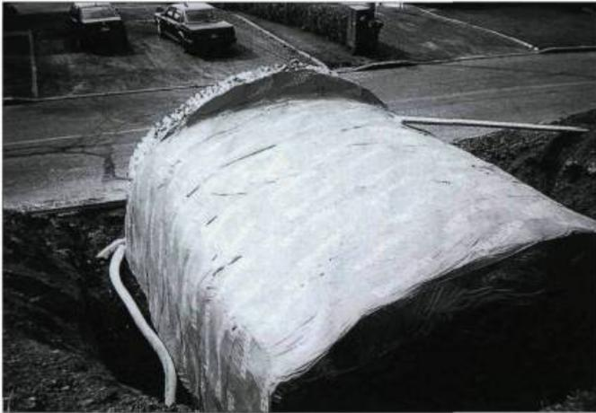
L'une des étapes de restauration du caveau consiste à le rendre étanche en installant un drain autour de la structure déterrée.
