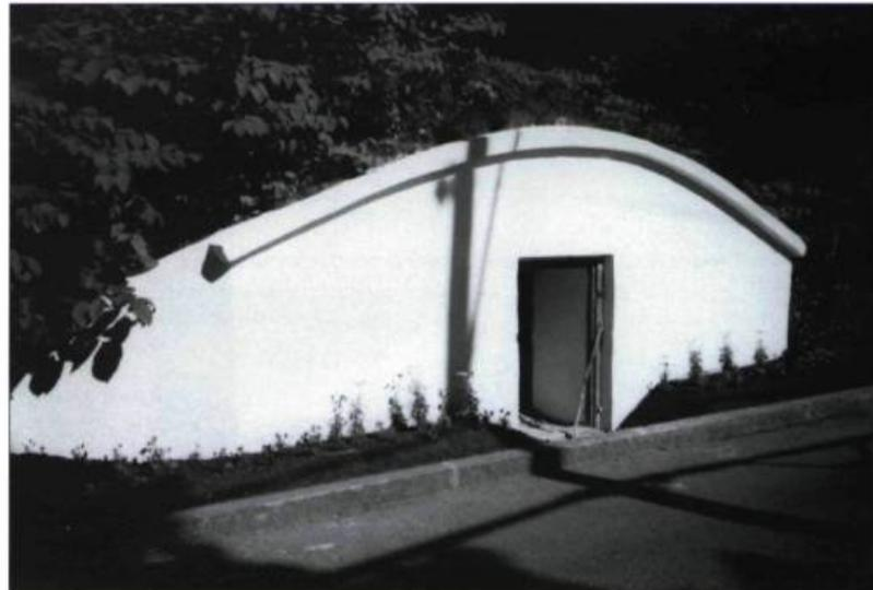
Après la réparation des joints de la façade, un badigeon blanc a été appliqué sur la façade du caveau sis au 8610, avenue Royale à Château-Richer afin de protéger la structure des abrasifs provenant de la route. En haut, on aperçoit le caveau avant les travaux.
