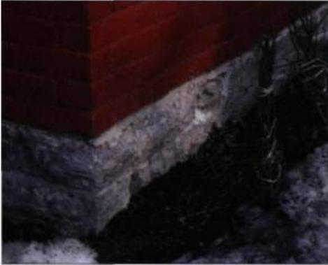
*La brique repose dans l'aplomb de l'assise de la maçonnerie en pierre de la fondation.*
