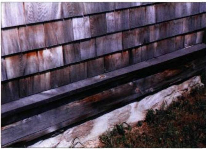
*L'installation d'un rejet d'eau, cette planche posée à angle, constitue la bonne façon d'assurer l'étanchéité de la construction de bois.*
