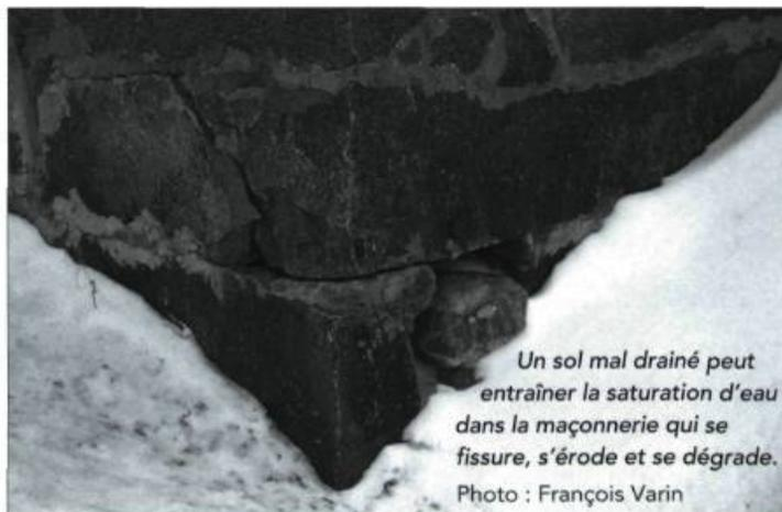
*Un sol mal drainé peut entraîner la saturation d'eau dans la maçonnerie qui se fissure, s'érode et se dégrade.*
